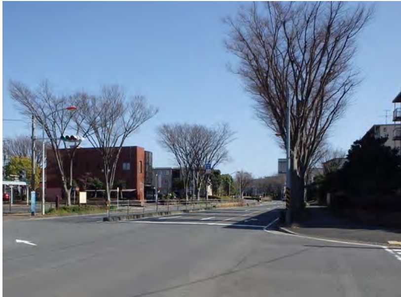
市道辻堂駅遠藤線
