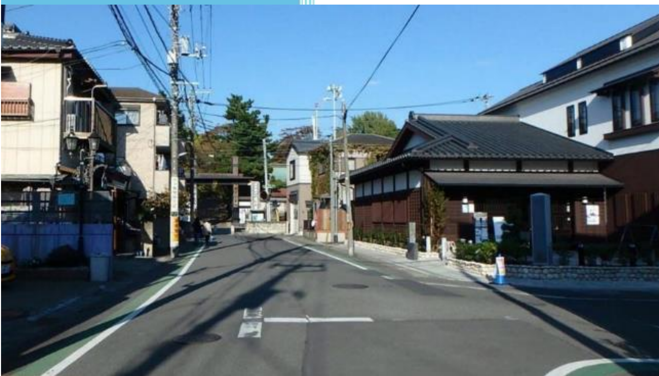
【無電柱化前】藤沢 394 号線（遊行寺前）
