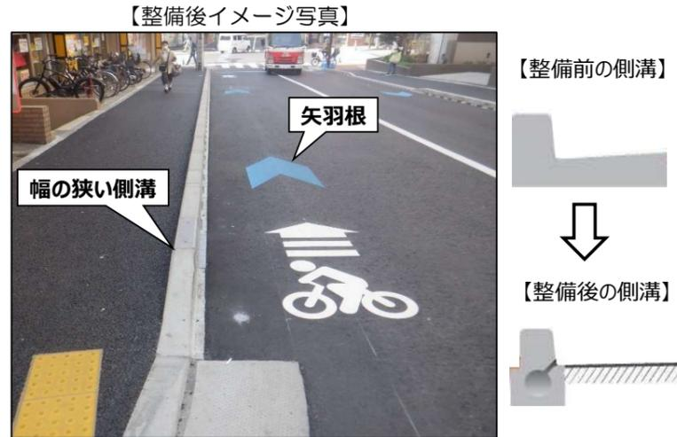
※横断歩道部は歩きやすい形状（セイフティブロック）に改修し、幅は整備前と同様の側溝になります。
