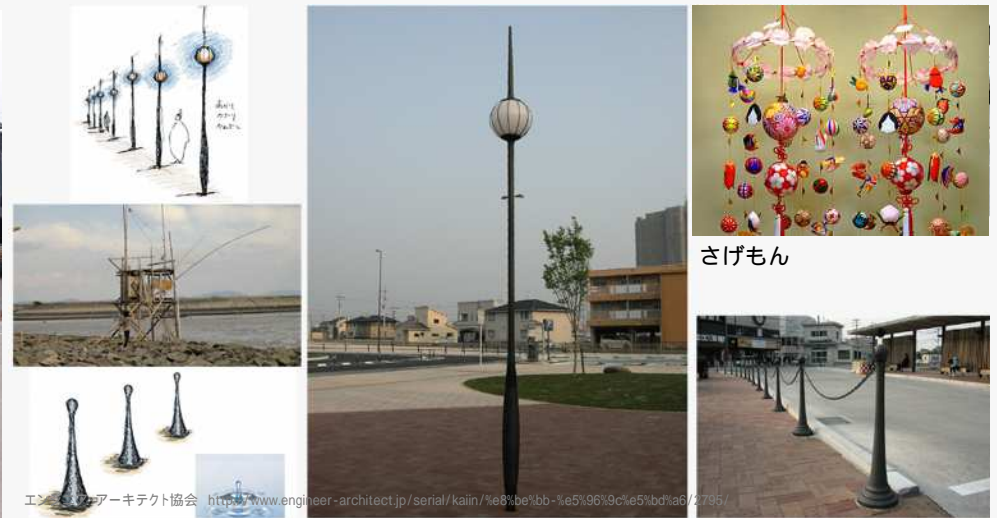
図 ストリートファニチャーは「水」、「さげもん」をモチーフとしてデザイン エンジニアアーキテクト協会 http://www.engineer-architect.jp/serial/kain/%e8%bb%bb-%e5%96%9c%e5%bd%a6/2795/
