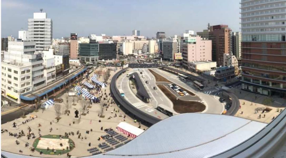
図 北口駅前広場 エンジニア・アーキテクト協会 http://www.engineer-architect.jp/serial/cate/eaproject100/2572/
