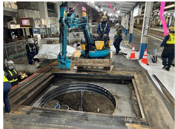
基礎杭(橋上駅舎)の施工状況
