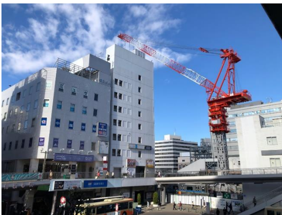
タワークレーン設置状況
