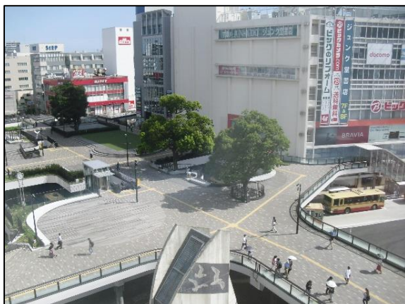
北口ペDESTリアンデッキ整備後
