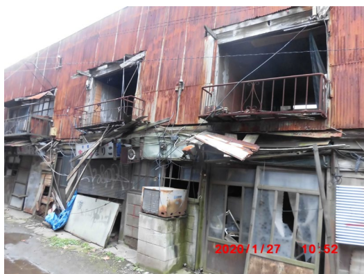
解体前の建物
