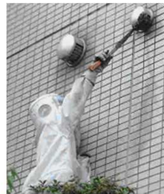
【スズメバチの巣の撤去風景】
