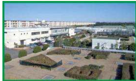
【辻堂浄化センター】
