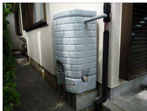
【雨水貯留槽設置例】
