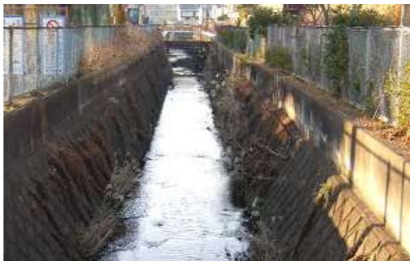
〔準用河川白旗川 改修前〕
