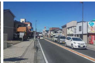
電線が地中化された国道467号
