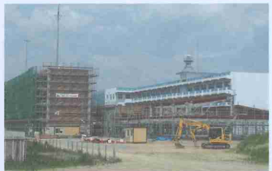
▲建設が進められている「東日本大震災伝承館」(左)
