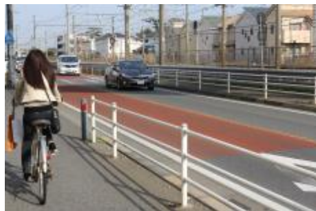
京楽園跨線橋人道橋西側
