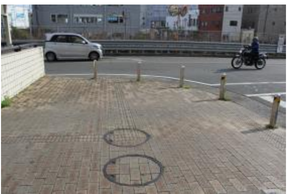
湘南辻堂跨道橋東側地下道入口裏
