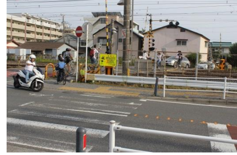
辻堂踏切北西側
