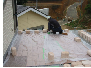
③ 土留め(縁石)を並べます。
