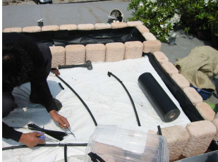
⑧ 灌水パイプを設置します
