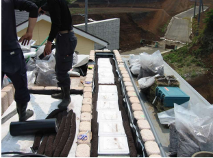
⑦ 保水シート・止水シートを敷きます。
