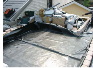
⑥ 耐根シートを敷きます。
