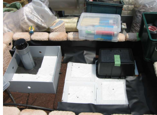
⑨ 灌水システムを設置します
