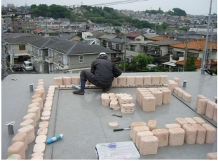
④ 土留め(縁石)を並べます。
