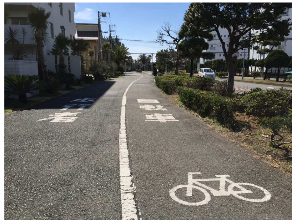
辻堂海浜公園付近の例
