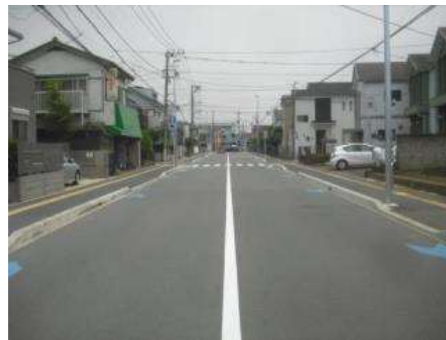
整備後状況写真
