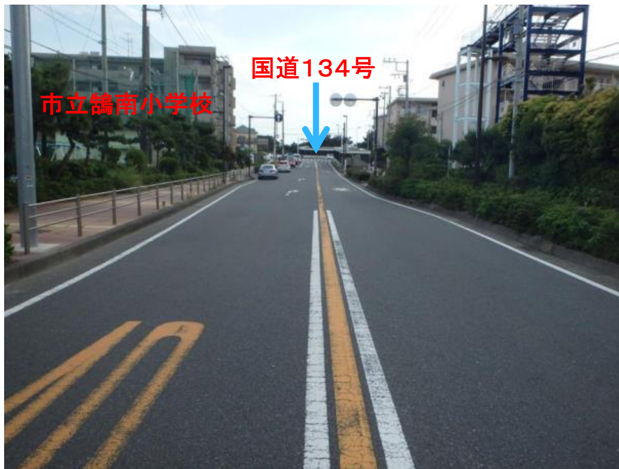
整備前状況 【国道134号近傍】
