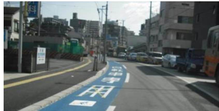
整備後状況写真
