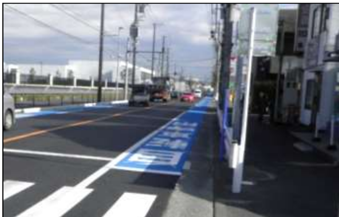
(参考写真) H27年度整備区間
