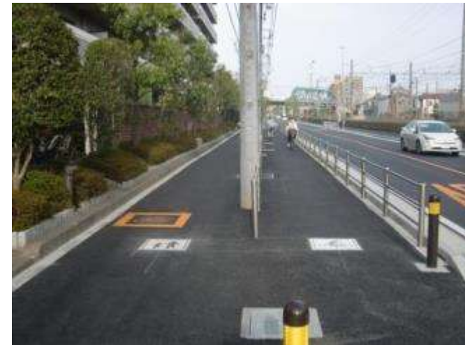
整備後状況写真
