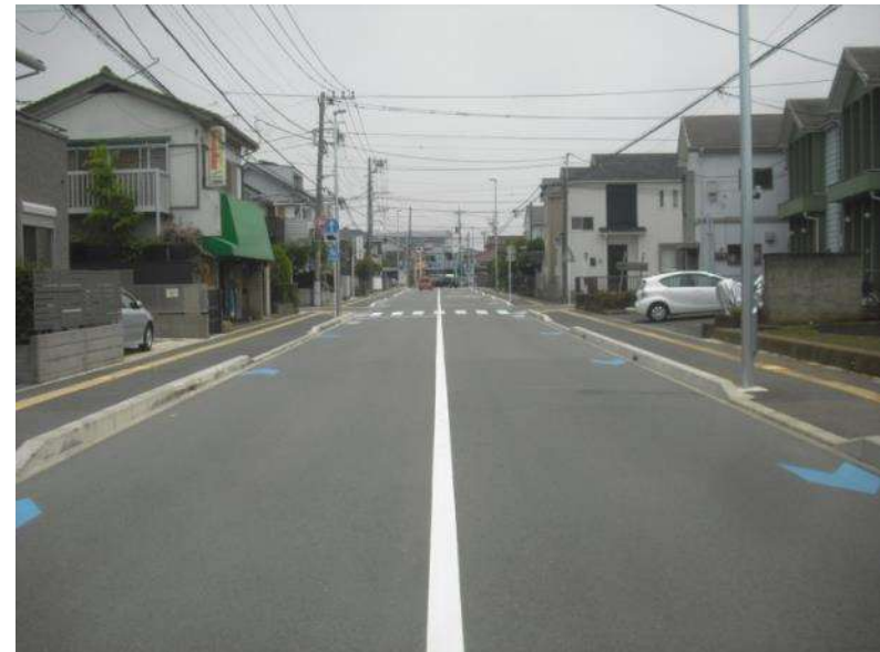
状況写真 (六会駅東口通り線)
