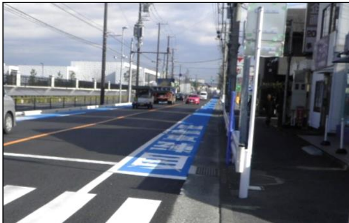
(参考写真) H27年度整備区間
