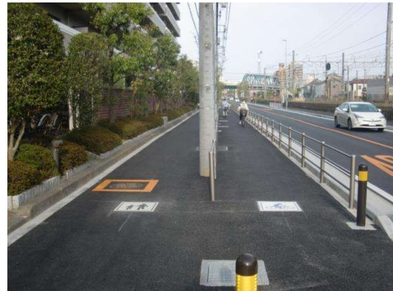
状況写真 (藤沢駅辻堂駅線)
