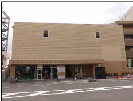
【藤沢駅北口第2自転車等駐車場】 駐輪施設の整備状況
