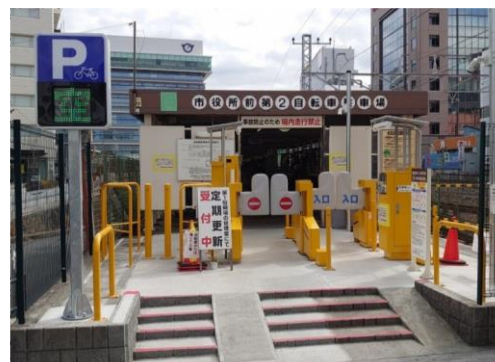
既存駐輪施設の機械化
